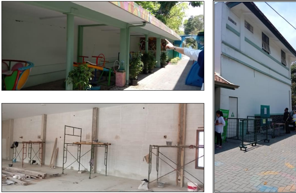
Gambar 3. Survei awal ke lokasi yang akan digarap menjadi mural
