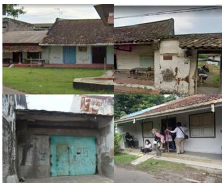
Gambar 8. Bangunan tua pada Desa Jamblang
