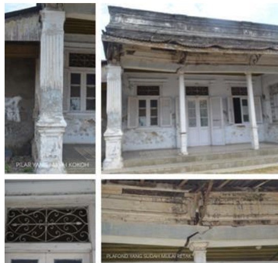
Gambar 9. Bangunan tua pada Desa Jamblang (bangunan 4)
