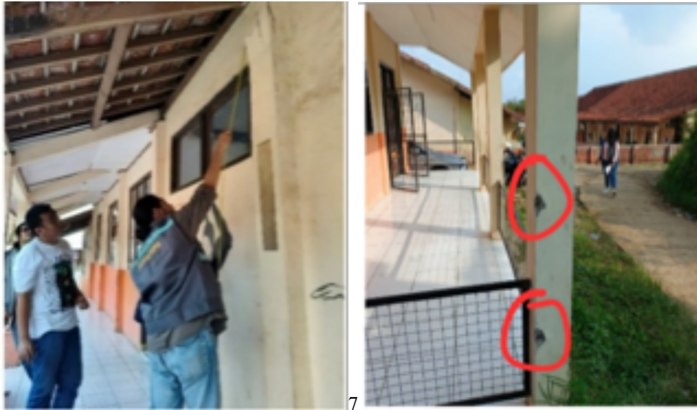
Gambar 4. Identifikasi kerusakan komponen struktural.
