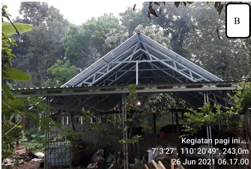
Gambar 2. Tampak depan kandang sebelum direnovasi (A) dan setelah direnovasi (B) (sumber: dokumentasi pribadi)
